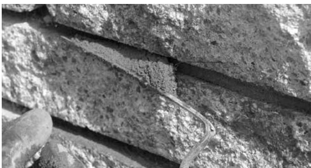
Nachdem die erste Reihe versetzt worden ist, wird der Fugenmörtel auf die Oberfläche der ersten Steinreihe aufgetragen und die zweite Steinreihe kann versetzt werden. Dabei muss die Schnur wieder neu angepasst werden. So wird kontinuierlich weiter verfahren, bis die Mauer fertiggestellt ist.
