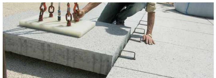
Großformatplatten sind aufgrund ihres Gewichtes und der erforderlichen Verlegeweise nur mit ausreichend dimensionierter Vakuumsaugtechnik zu verlegen. Hierbei kommt es nicht nur auf die Tragfähigkeit der Vakuumtechnik, sondern vor allem auch auf deren Leistungsfähigkeit und die Beschaffenheit der Steinoberfläche an. Mietserviceunternehmen finden Sie auf Seite 146.
