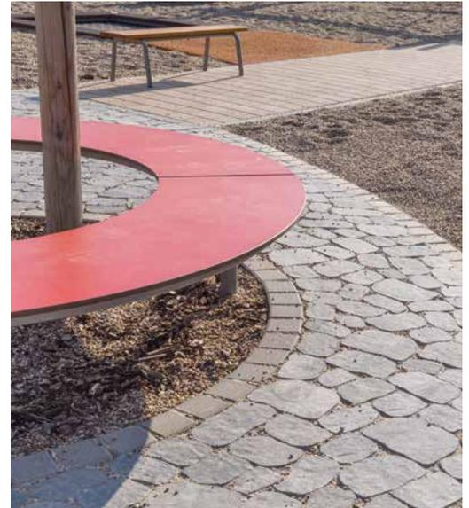
Die Verlegung des Pflasters im 7-Stein-System bedarf aufgrund der polygonalen Steinform und der fehlenden Abstandhalter ein wenig Übung, konnte dann aber durch die beauftragte Firma VSTR problemlos verlegt werden.
